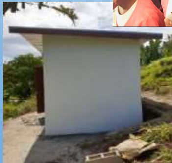
Bâtiment abritant le système de potabilisation de l'eau
